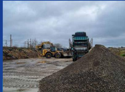
Plateforme de recyclage des déblais excavés
